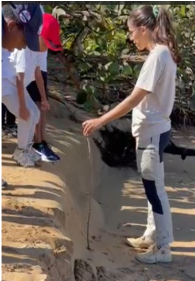
Affaissement du sol
