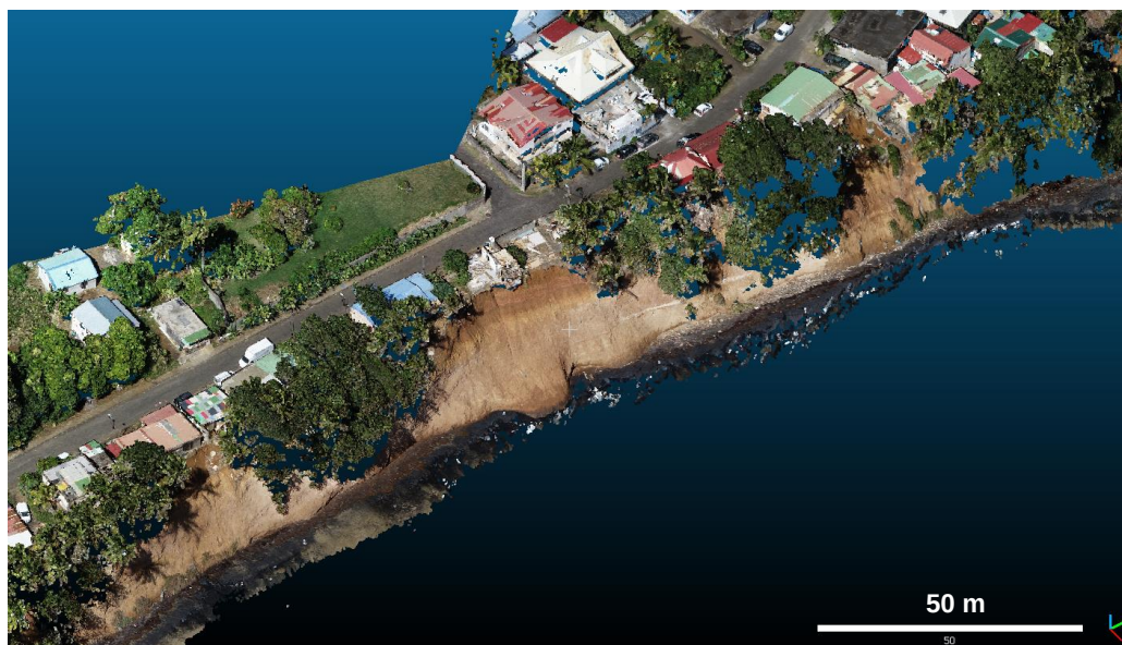
Illustration 17 –Modèle topographique 3D du site de la falaise de Carangaise sur la commune de Capesterre-Belle-Eau réalisé à partir de mesures photogrammétriques par drone en janvier 2022
