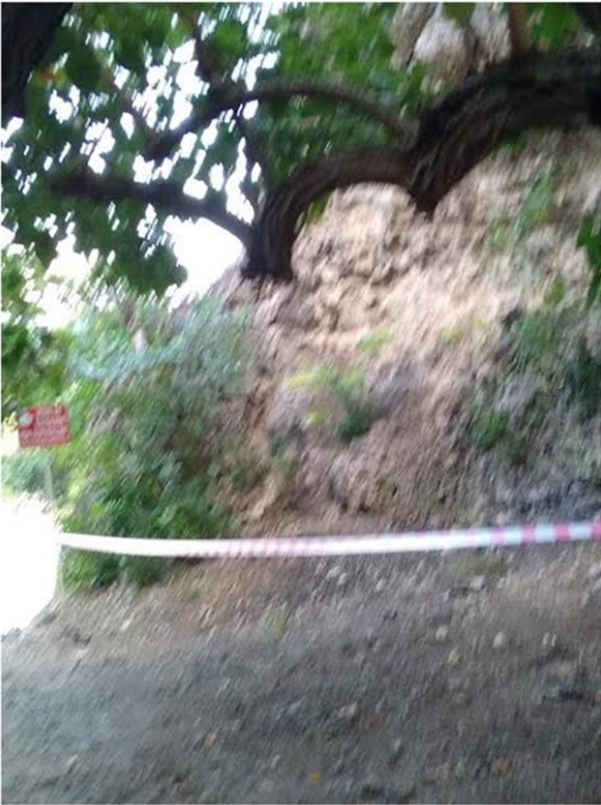
Mise en place de rubalise en bord de passage du public pour prévenir de la dangerosité du site
