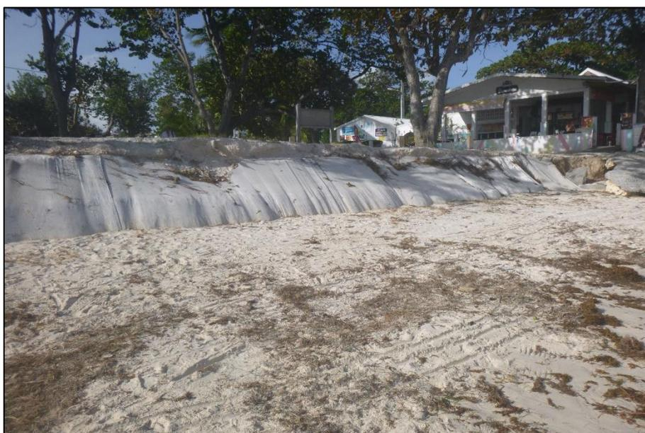
*Illustration 84 - Affleurement du géotextile installé suite aux travaux de protection du cimetière réalisés par la DAC en 2015 (BRGM, 25/09/2017)*
