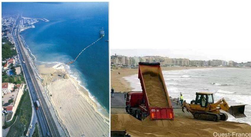
*Illustration 22 - Exemple de rechargement en sable au moyen d'une drague en mer (à gauche – Virginia beach, USA) ou par camions (à droite- La Baule, France)*
