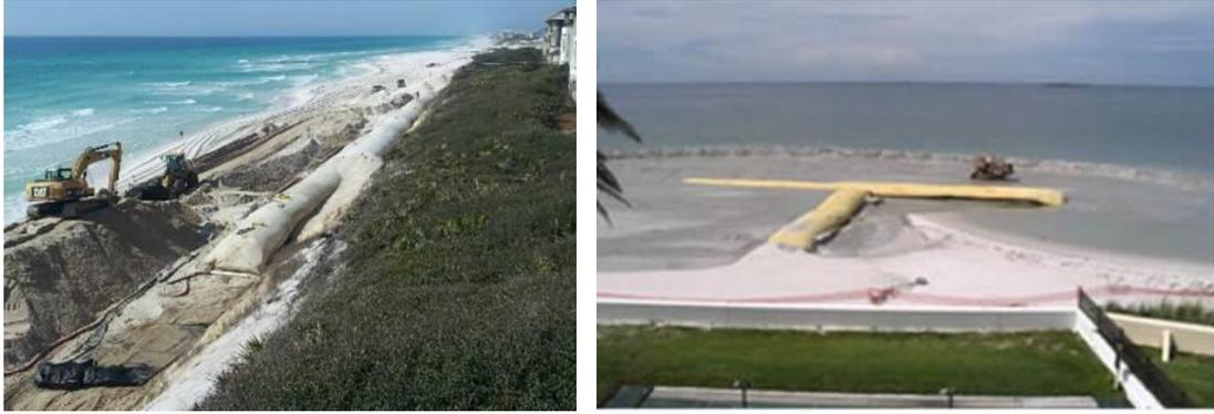
Illustration 29 - Exemple de structures en géotextiles longitudinal en pied de dune (à gauche) ou en épi en T (à droite).
