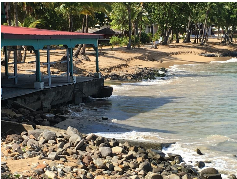
Illustration 6 – Erosion de la partie orientale de la plage et déchaussement de la terrasse du centre nautique (BRGM, 2016)
