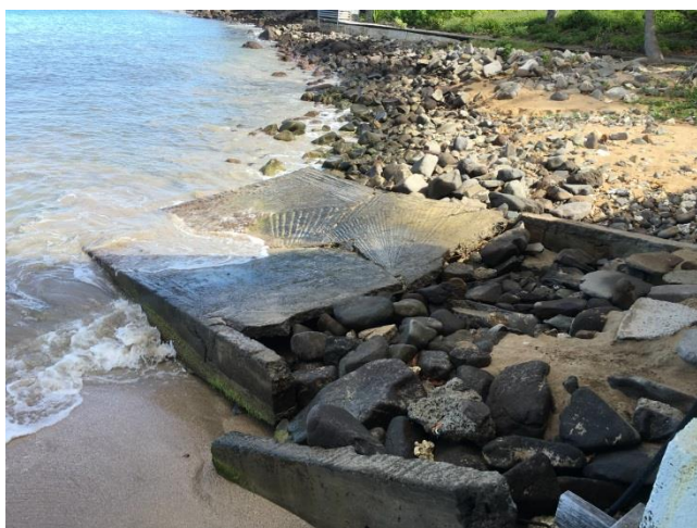
Illustration 7 – Dégradation de la cale de halage et ensablement de la terrasse du centre nautique (BRGM, 2016)
